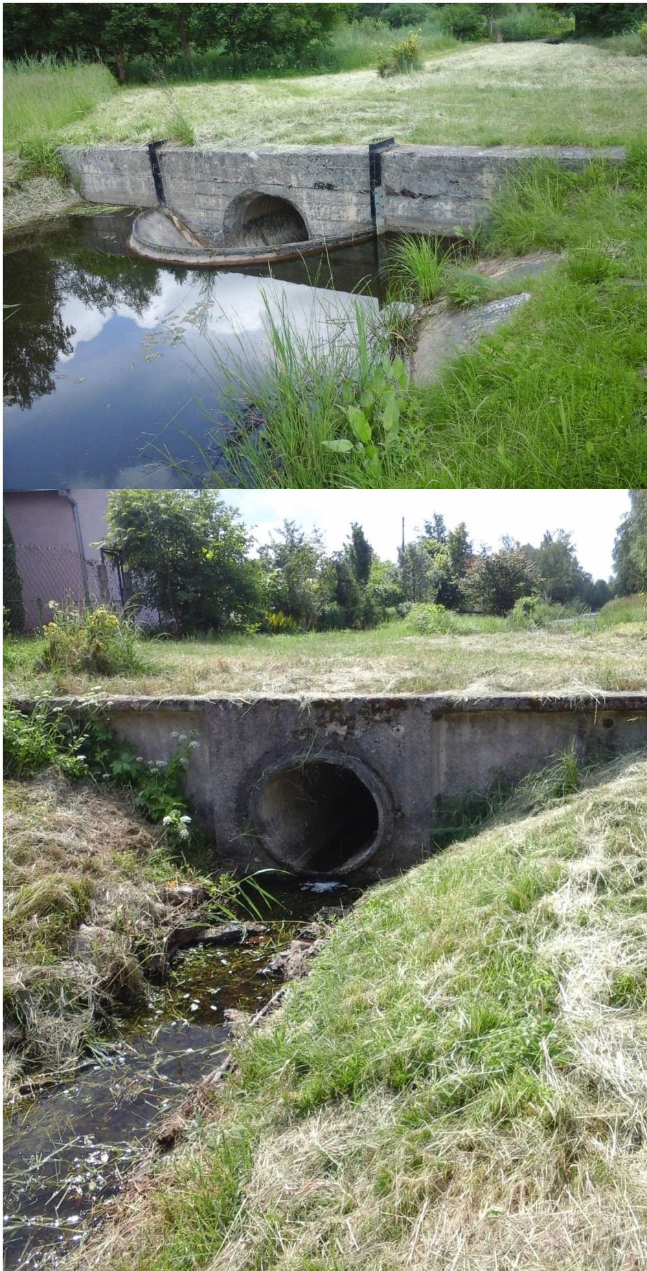
28 pav. Hidrotechninis įrenginys vandens lygio pakėlimui Rėkyvos ežero šiaurinėje dalyje
